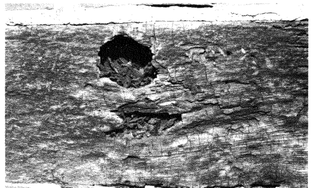
Bild 5: Vollständige Zerstörung eines Riegels durch holzzerstörende Ameisen
