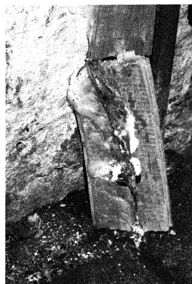
Bild 5: Vollständige Zerstörung eines Riegels durch holzzerstörende Ameisen
